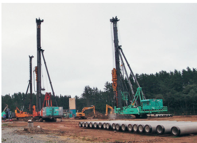
原子力発電所付帯設備杭打工事
