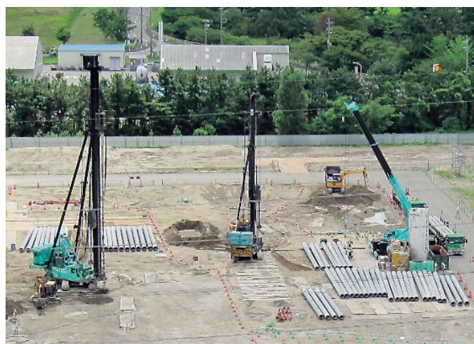
火力発電所建設杭打工事
