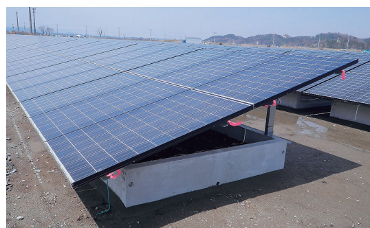
ソーラーキーパー 太陽電池モジュールのコンクリート製基礎架台
