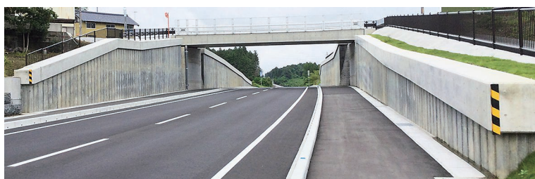
PC-壁体 連続して壁状に設置する自立式土留め構造物
