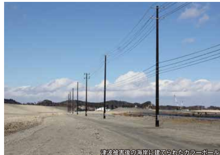
津波被害後の海岸に建てられたカラーポール
