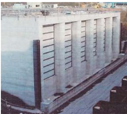
PC製角落し 火力発電所や原子力発電所の取水口や放水路に使用されている
