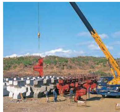
消波ブロック「アクロポッド®」 独特な形状により一層積みでも確実な被覆ができる経済的な消波ブロック
