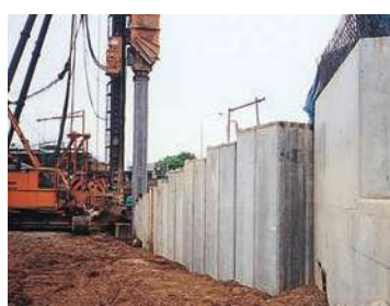
PC-壁体 連続して壁状に設置する自立式土留め構造物
