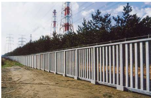
PC周囲柵 発電所・変電所の敷地境界に数多く採用されている
