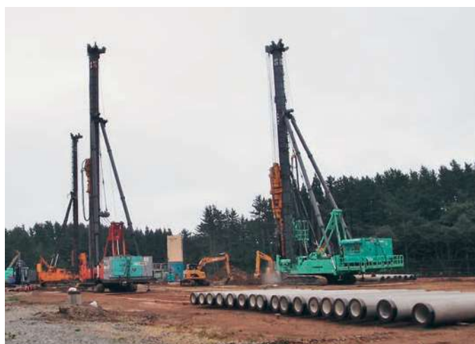
原子力発電所付帯設備杭打工事
