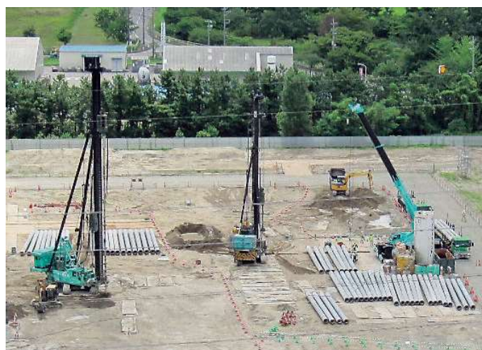
火力発電所建設杭打工事
